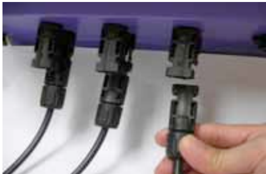
Fig 3.3.2.2 Collegamento di terminale FV -
