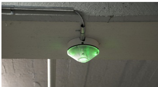
Fig. 36 : Capteurs montés en hauteur diminuée
