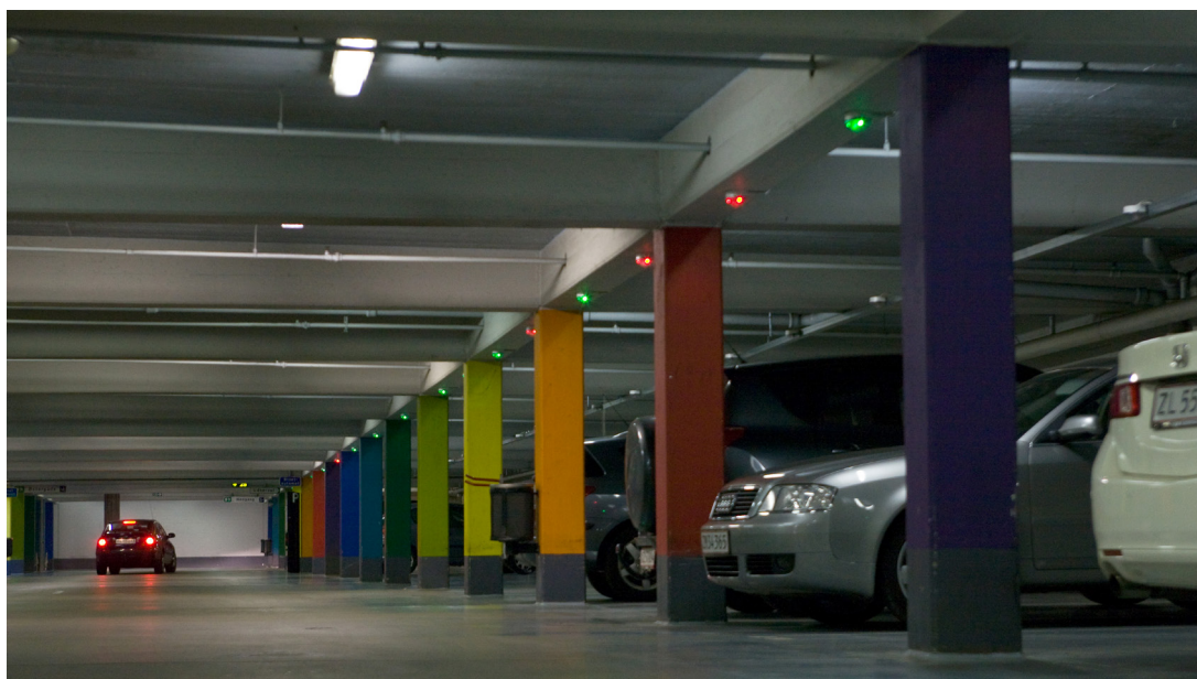
Fig. 18 : Voie avec indicateurs lumineux extérieurs fournissant une excellente visibilité
