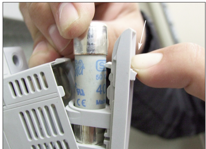
4. Hacer presión hacia abajo en la pestaña del portafusibles para colocar o retirar el fusible
