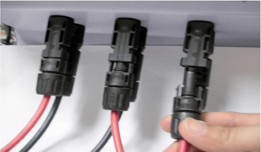
Fig 3.3.2.3 Conexión de terminal FV +
