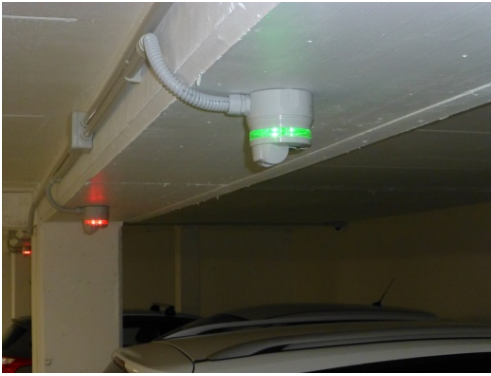
Abgesenkte Sensorinstallation
