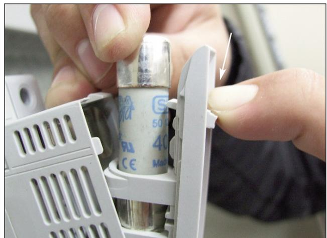
4. Halteclip der Sicherung herunterdrücken, um die Sicherung zu entnehmen oder einzusetzen.
