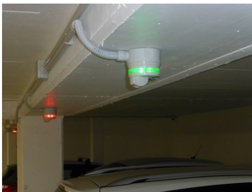
降低传感器高度的安装
